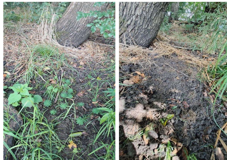
Slika 67: Odsek ID 97 pred in po odstranjevanju. (Lastni vir)
