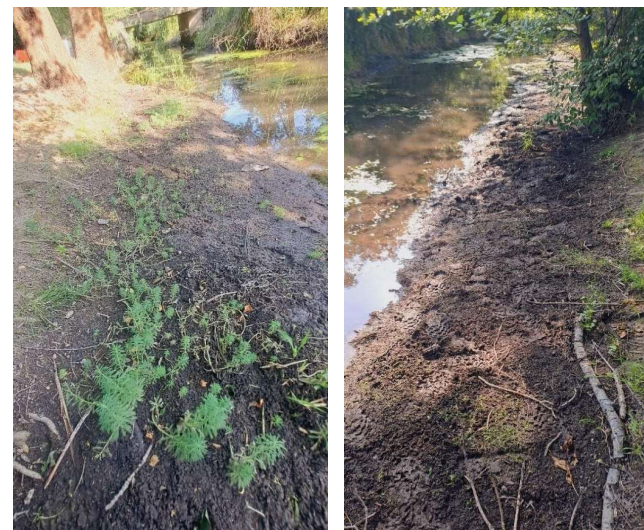
Slika 28: Odsek ID 103 ; stanje pred in po odstranjevanju (Lastni vir)
